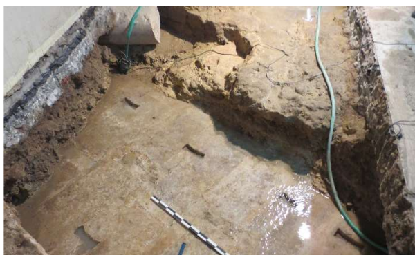
Fig. 3 - Pormenor da muralha/paredão limite do criptopórtico, com a construção combinada em opus quadratum - silhares - e opus caementicium - betão romano, descoberto no interior do edifício da Rua da Prata, 45-51/ Rua de São Julião, 86-106
