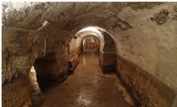
Fig. 1 - Aspeto do interior da área visitável do criptopórtico romano: atual galeria de entrada, pela Rua da Conceição
