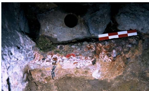
Fig. 3- Pormenor do revestimento em opus signinum (Foto: Manuela Leitão).
