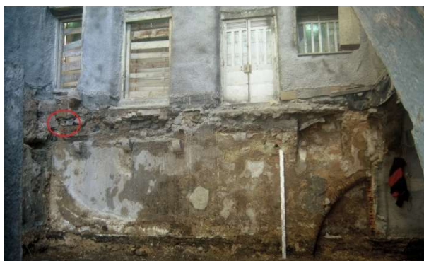
Fig. 2- Parede de tardo do edifício onde foi detectado parte da estrutura romana (Foto: Manuela Leitão).
