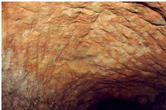
Fig. 4 - Galerias de Vale de Gatos. Marcas das ferramentas utilizadas pelos mineiros na abertura das galerias.
