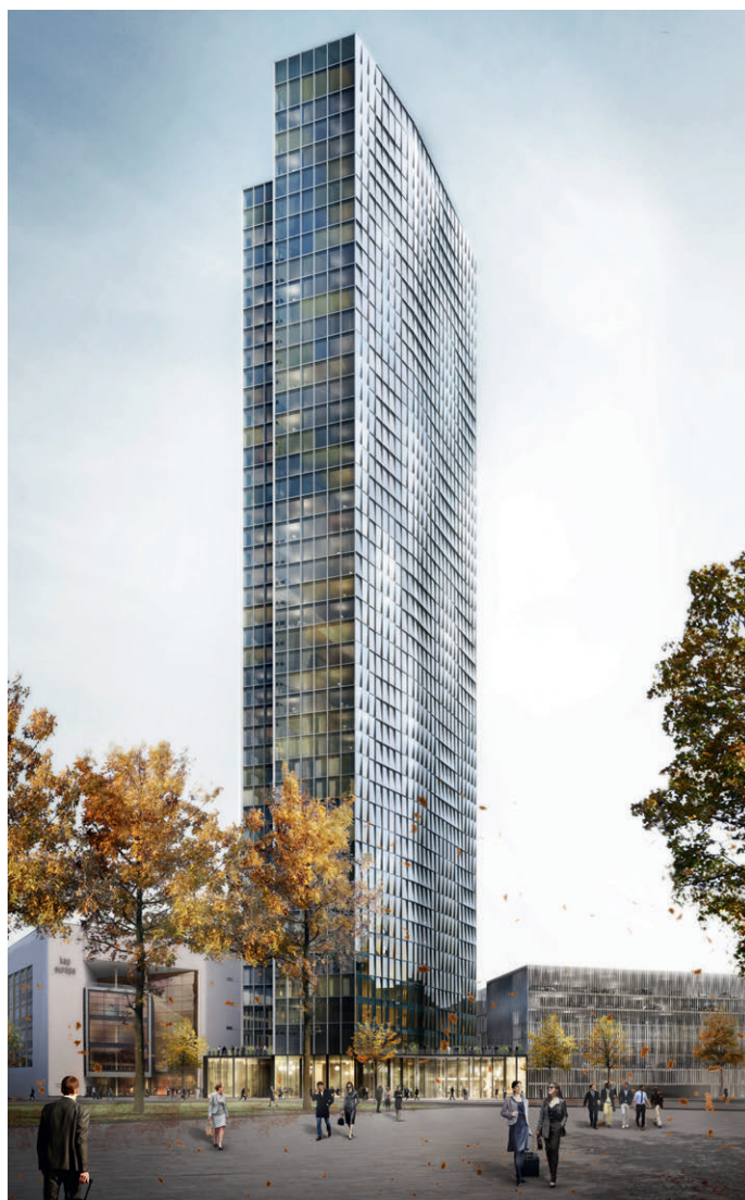
Blick zum Haupteingang mit Bürolobbies und Hotelzugang
