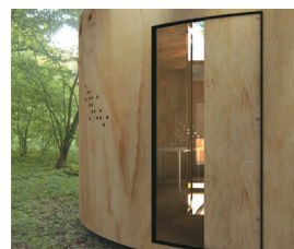
Zugang (Blick in Innenraum)
